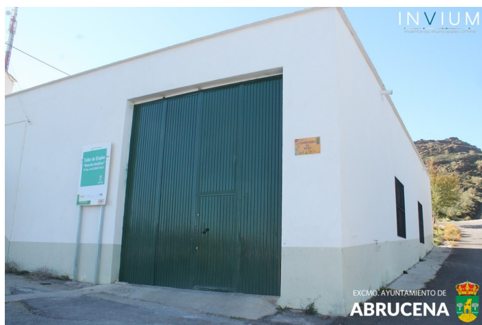
Fachada en Ángulo
