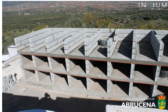
Nichos en construcción
