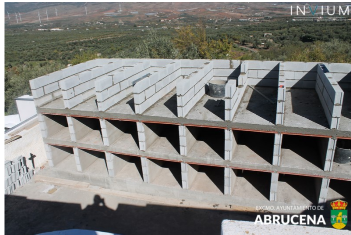
Nichos en construcción
